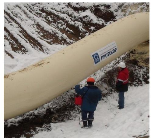
требованиями ОАО «Газпром» противокоррозионный полиуретановый двухкомпонентный материал **Protegol UR-Coating 32-60**. Очевидные преимущества материала и покрытия –
